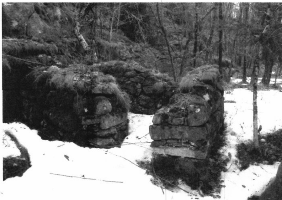
Solid mur etter jordkjeller i Mjøhusdalen. Utvendig mål ca. 4 x 3 m.
