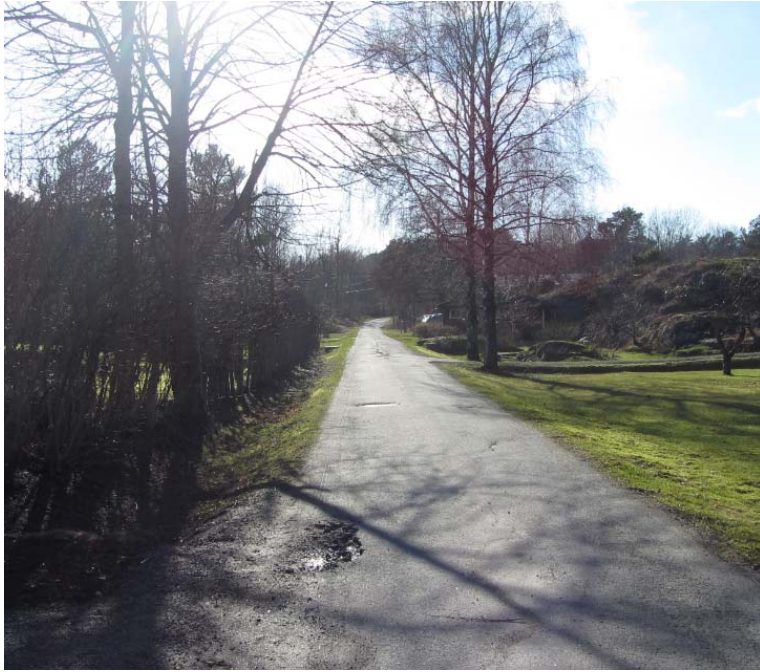
Figur 21. Borøykilveien slik den er i dag.
