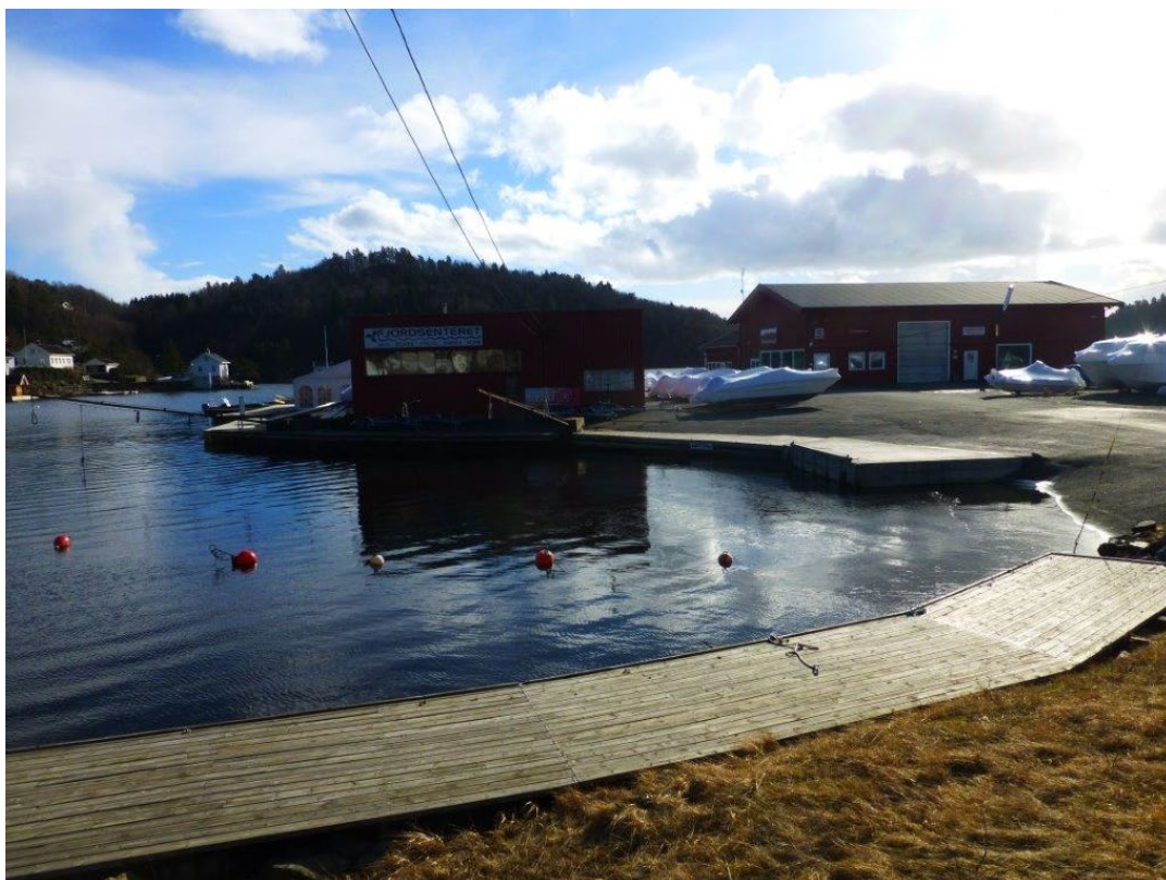
Bildet viser en del av bryggeanleggene og innregulert slipp. Fotografiet er tatt vinterstid.
