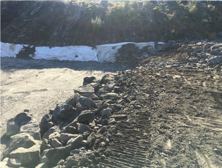
FIGUR 9 DUK MOT EKS FYLLING MOT LYNGMYRHALLEN
