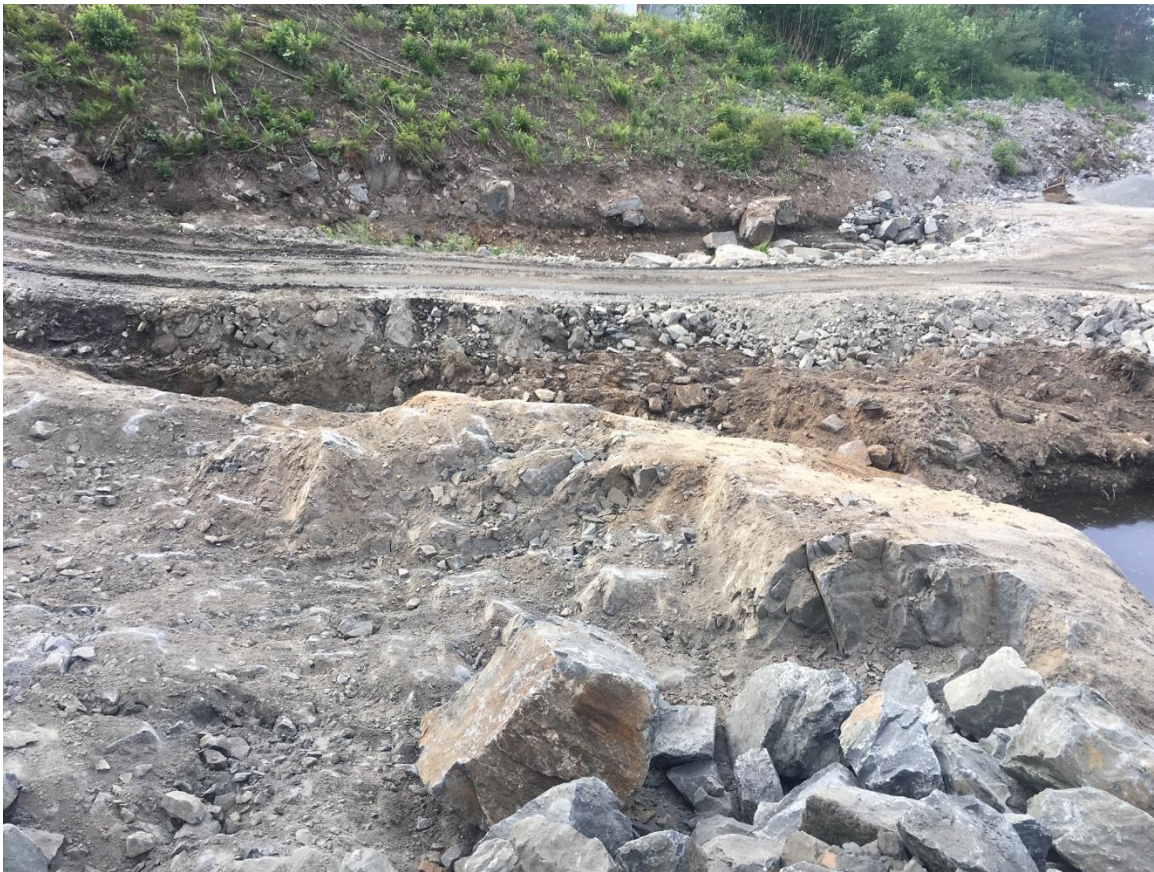
FIGUR 4: SKILLE MELLOM FJELL OG MYRFORTRENGING. BILDE ER TEKE FRÅ NORD, OG VISER DET SØRVESTLEGE HJØRNET AV TOMTA
