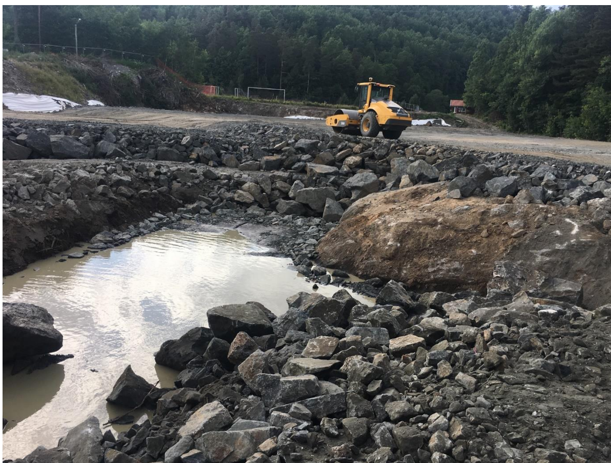
FIGUR 2: SKILLE MELLOM FJELL OG MYRFORTRENGING. BILDE ER TEKE FRÅ SØRAUST.
