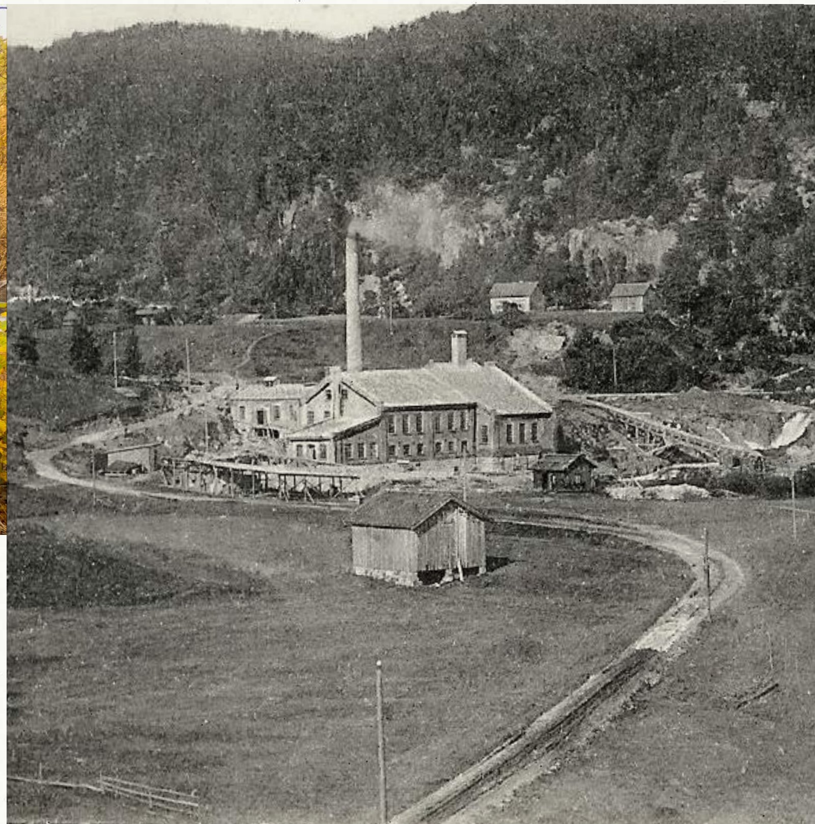
Sliperiet på Fosstveit var i drift frem til 1970. Sliperiet brukte vannkraft fra elva, og tømmeret ble i stor grad fløtet på Storelva. Vannveien sørget dermed både for transport og energi.
