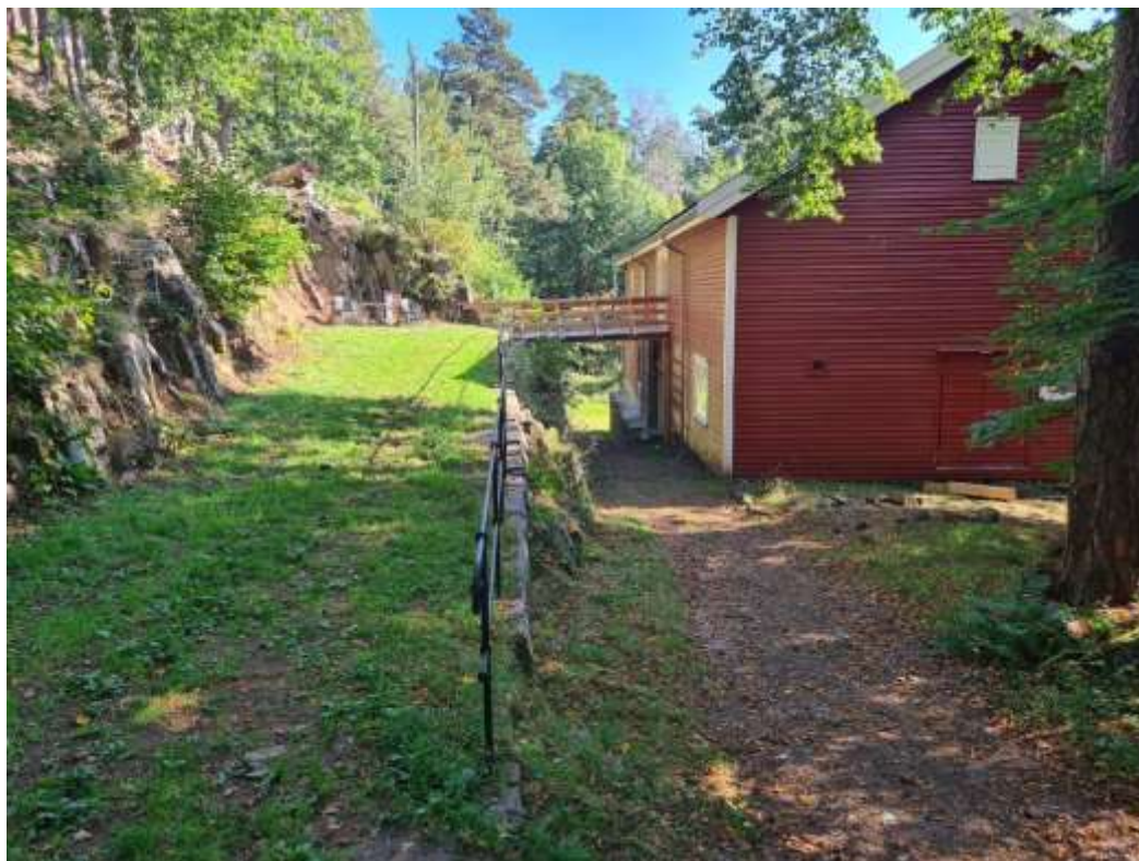
Låvebroa er ferdig, smijernsrekke på plass, trær er felt og grasset har blitt grønt. Veldig godt resultat!
