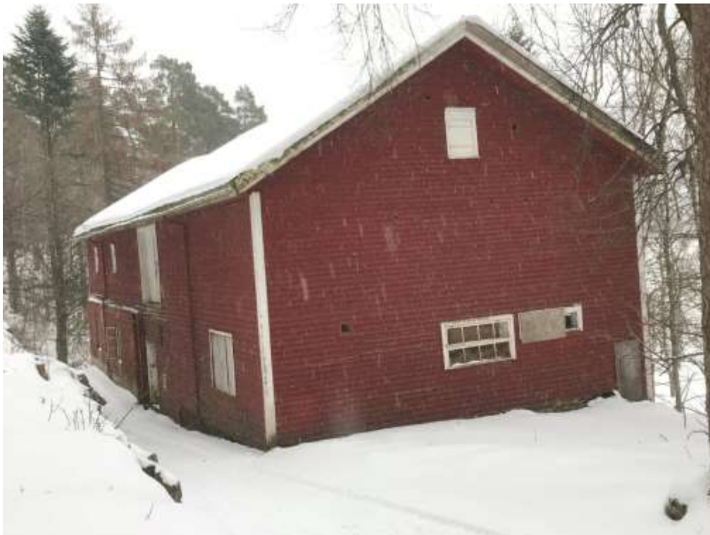
Låven før restaureringen startet. Låvebroa var da helt borte, uvisst når den falt eller ble tatt ned.
