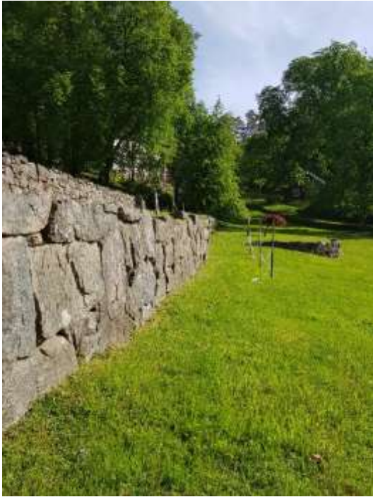
Før arbeidet startet lente muren seg utover og utgjorde en fare.
