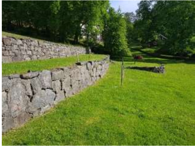
Før arbeidet startet lente muren seg utover og utgjorde en fare.
