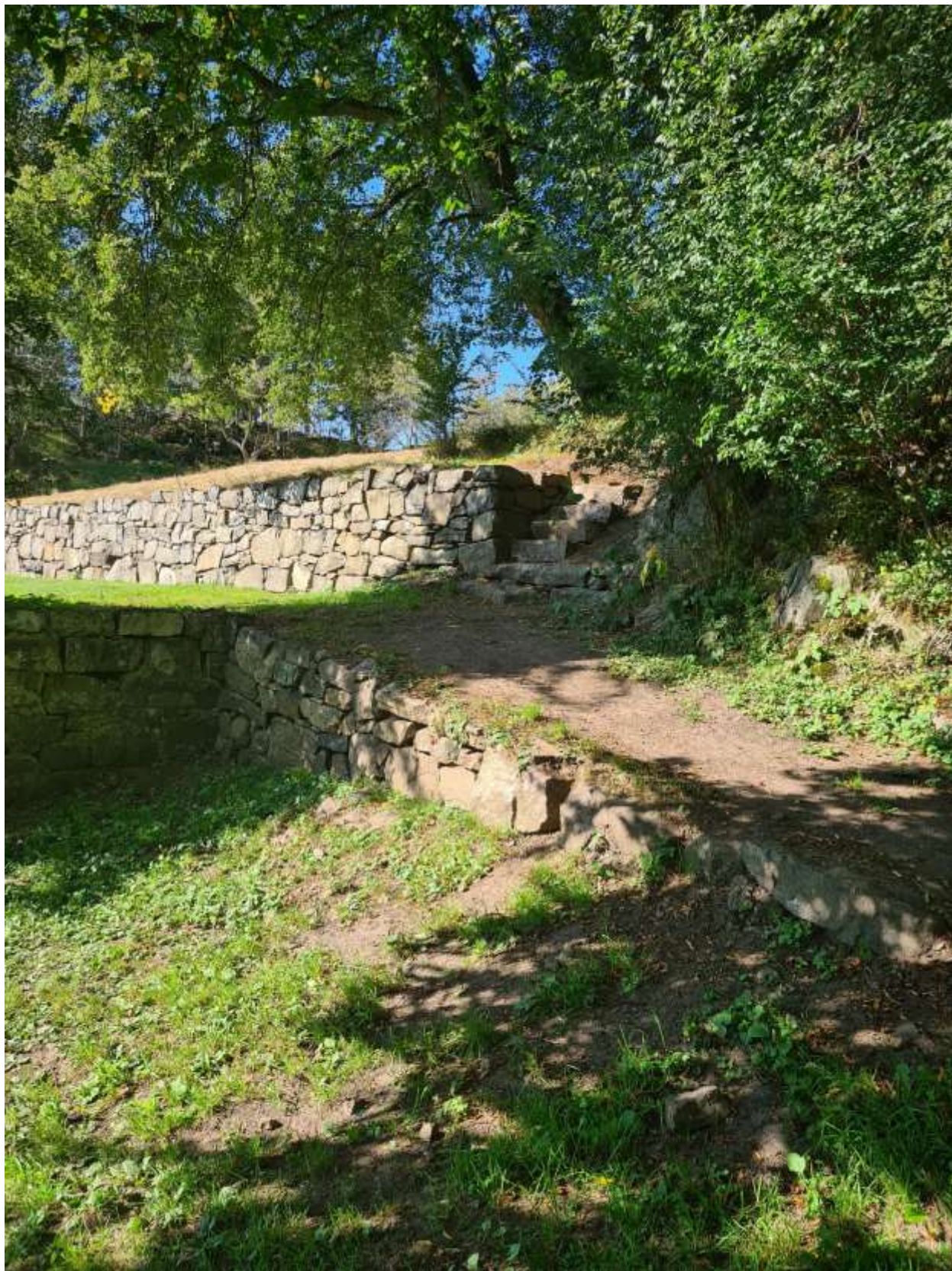
Vingemuren og trappa ble fikset i samme slengen.
