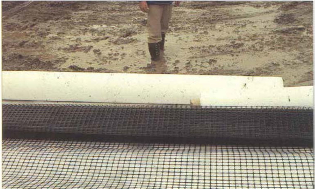
Figur 1-4- 3 Utlegging av armeringsnett med underliggende fiberduk.
