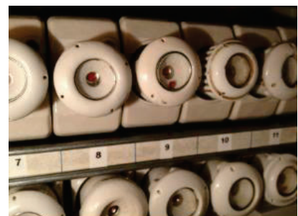
Skrusikringer. Foto: Elsikkerhetsforeningen.
