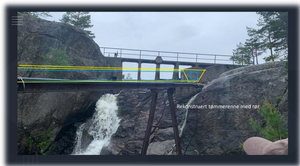
Bilde 16-17. Viser begynnelsen av tømmerrennen fra dammen
