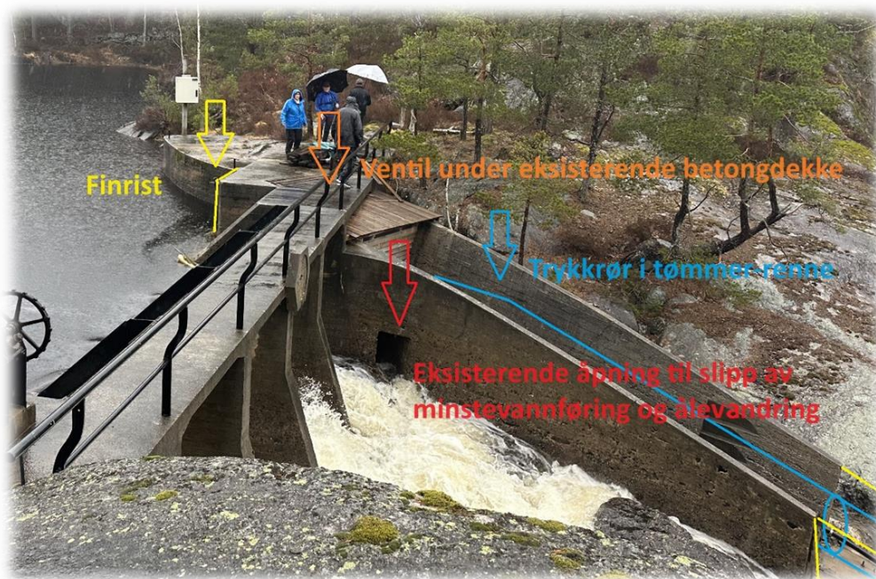
Bilde 18. Inntaksområdet sett nedenfra og ovenfra
