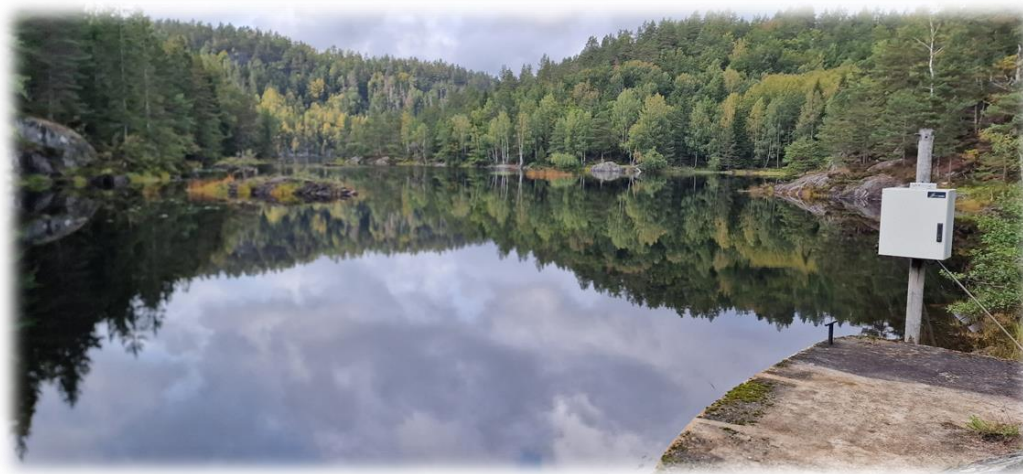
Bilde 19 Vannspeilet i kraftverksdammen, sett nordover fra damkrona
