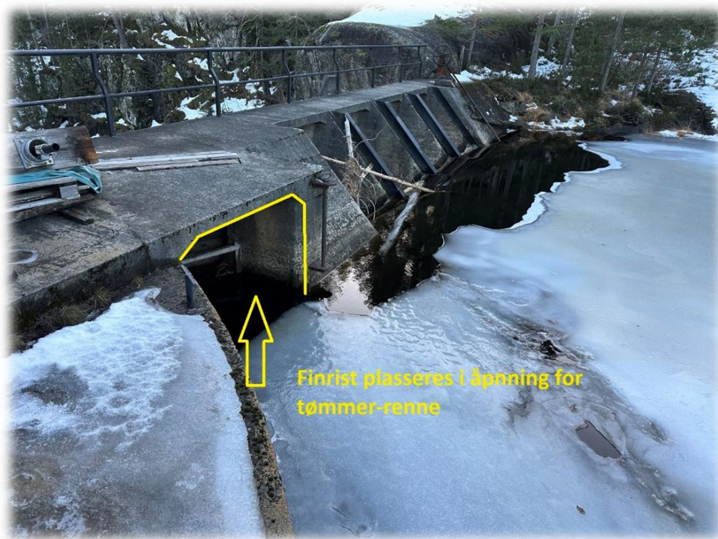
Skisse 5 Skisse inntakskonstruksjon
