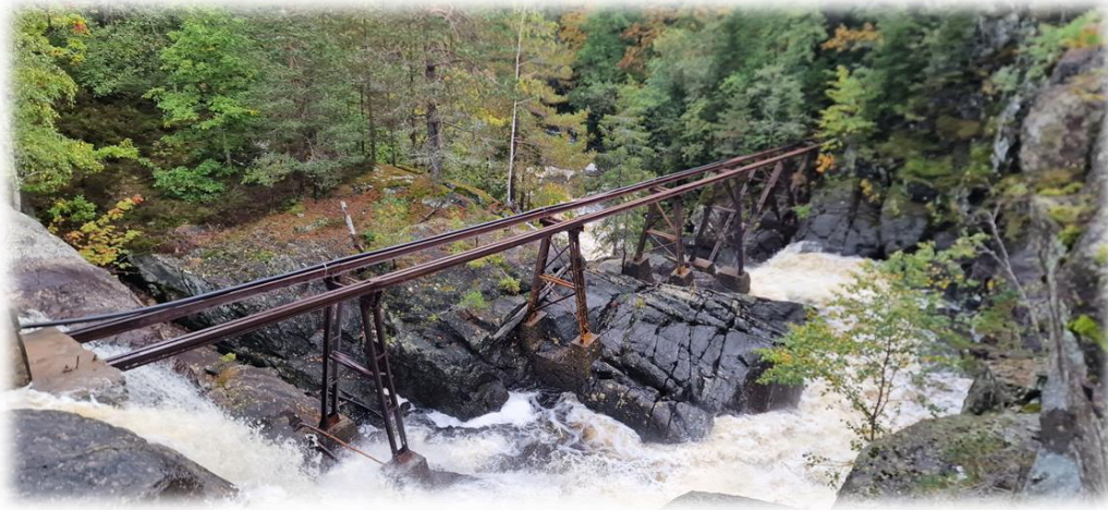
Bilde 7 Gammel konstruksjon for tømmerrenne
