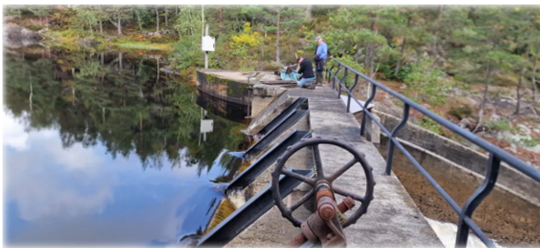
Den gamle fløtningsdammen ved Savann hvor det planlegges et nytt inntak.
