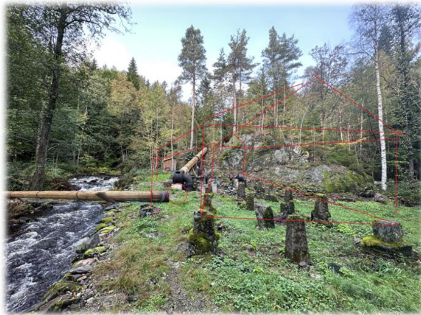
Bilde 21 Fundamentområde for gammel og ny Kraftstasjon
