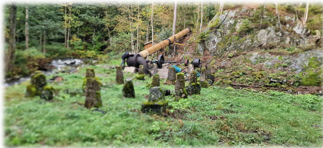
Bilder 22 viser gamle konstruksjonsfundamenter for sagen, med turbinen og det re-bygget innløpsrøret for den gamle turbinen
