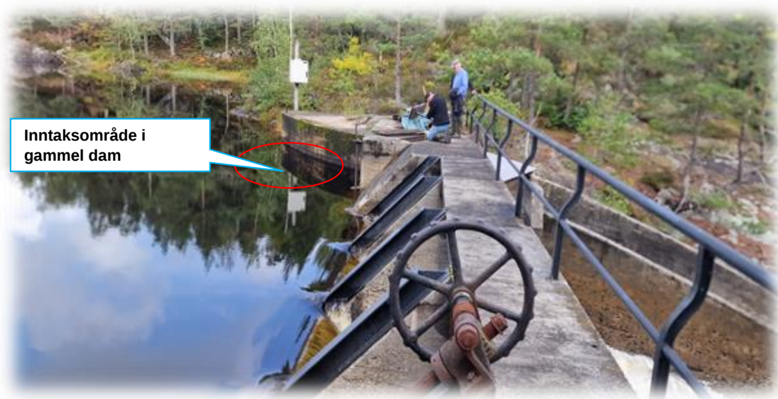
Bilde 15 Dammen hvor inntakskum med finrist planlegges
