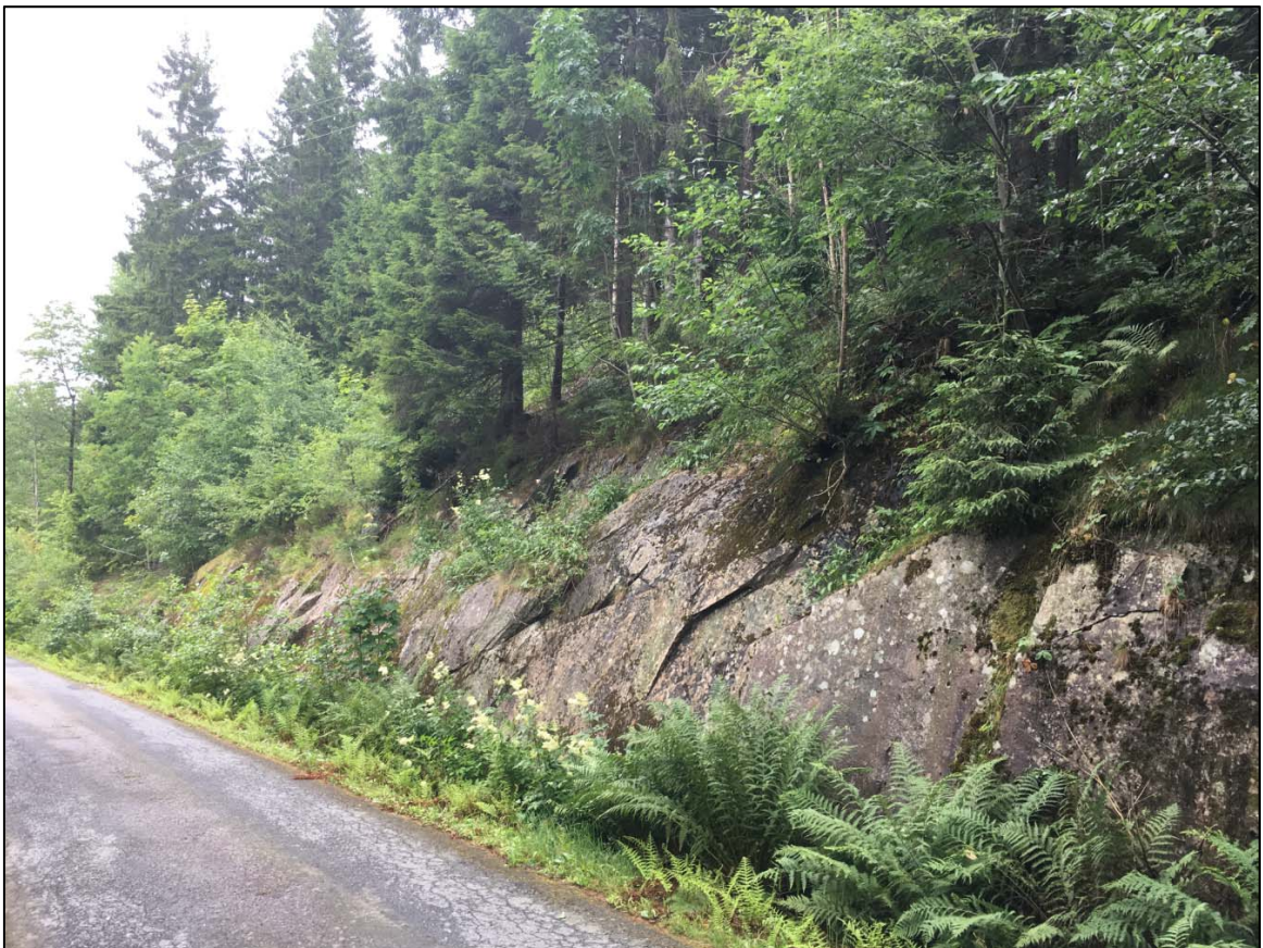
Figur 5. Bergblotning rett utenfor planområdet. Ved veien ned til Lagveien 580.
