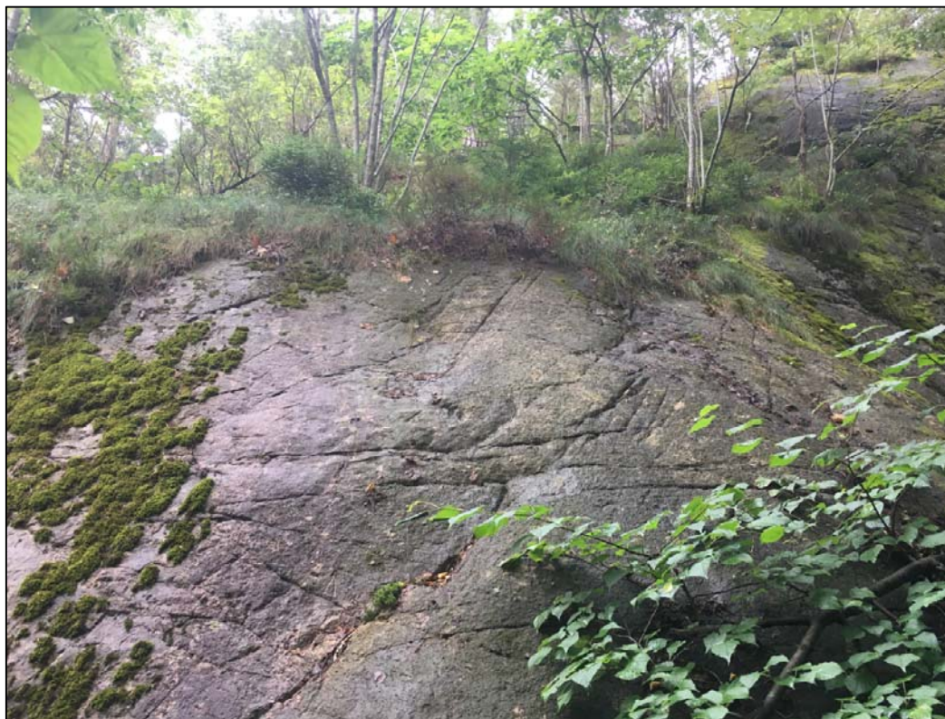
Figur 9. Moderat oppsprukket og storblokkig berg. Bildet er tatt utenfor planområdet og fra området sør for Åkvåveien.
