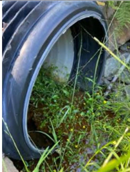
Bilde 2, utløp i kulvert
