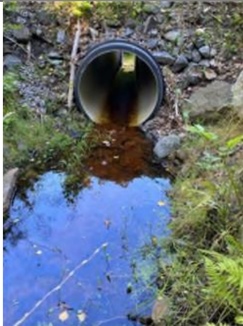
Bilde 1, innløp i kulvert
