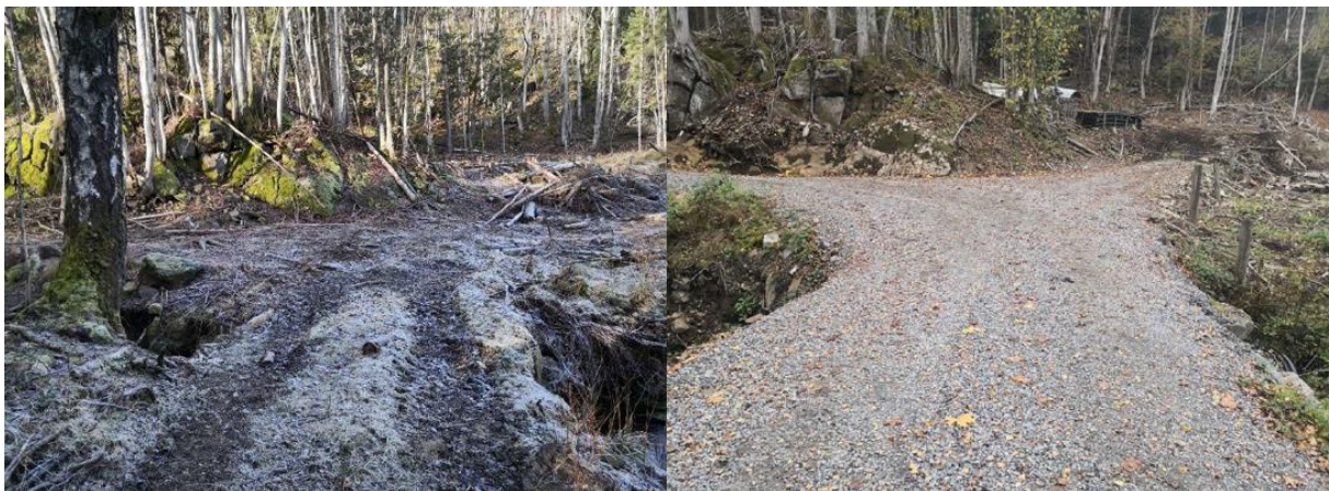
Figur 14: Oppgradering av kulvert/krysning av Hanthobekken.
