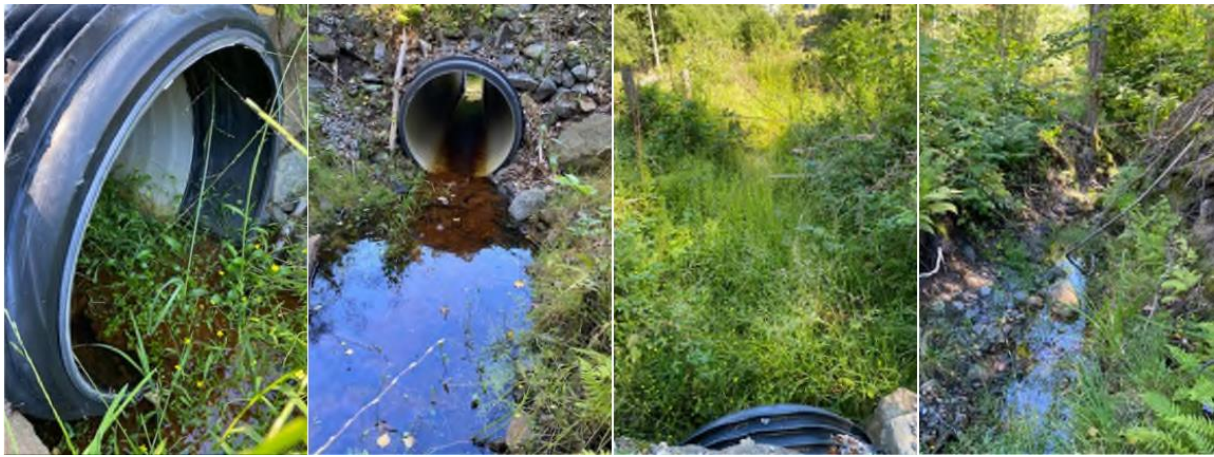
Figur 13: Bilder av den etablerte kulverten. Fra venstre: Kulvertens innløp, kulvertens utløp, oppstrøms og nedstrøms.
