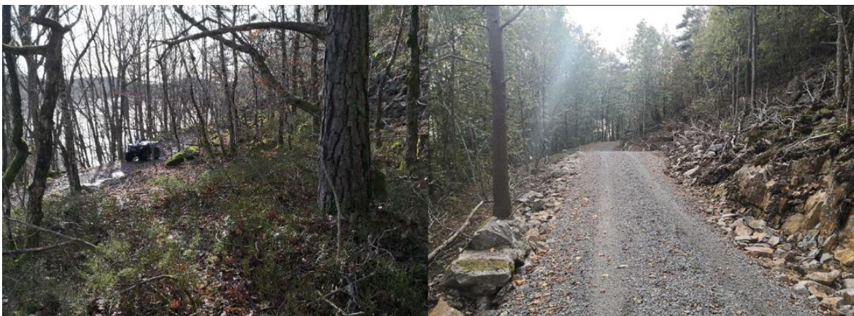
Figur 12: Stedet hvor nyanlagt trasé av Liaveien møter traktorveien.
