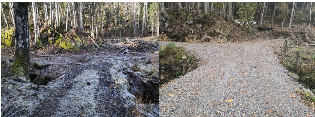
Figur 14: Oppgradering av kulvert/krysning av Hanthobekken.
