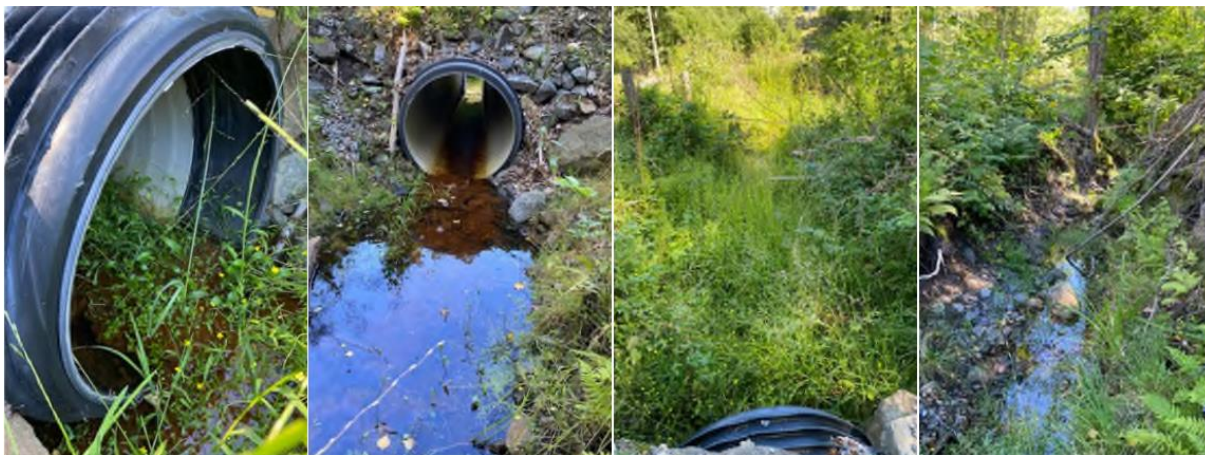
Figur 13: Bilder av den etablerte kulverten. Fra venstre: Kulvertens innløp, kulvertens utløp, oppstrøms og nedstrøms.
