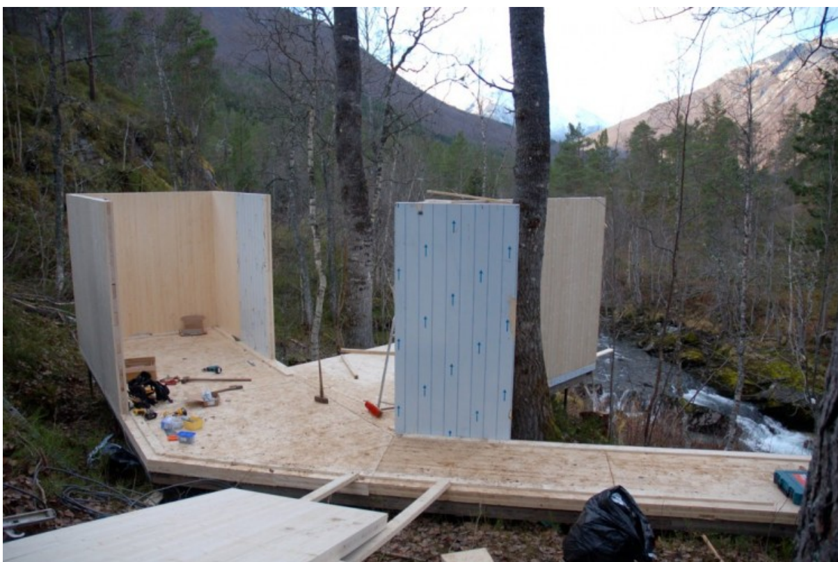
Vegger av massivtre festes til plattformen, alt uten bruk av kran. (Arkitekt: Jensen og Skodvin foto: Juvet.com)
