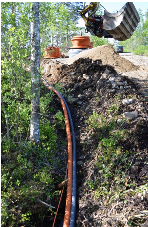
Vann og avløp lagt i en grunn grøft tett mot eksisterendevegetasjon. (Foto: isoterm.no)
