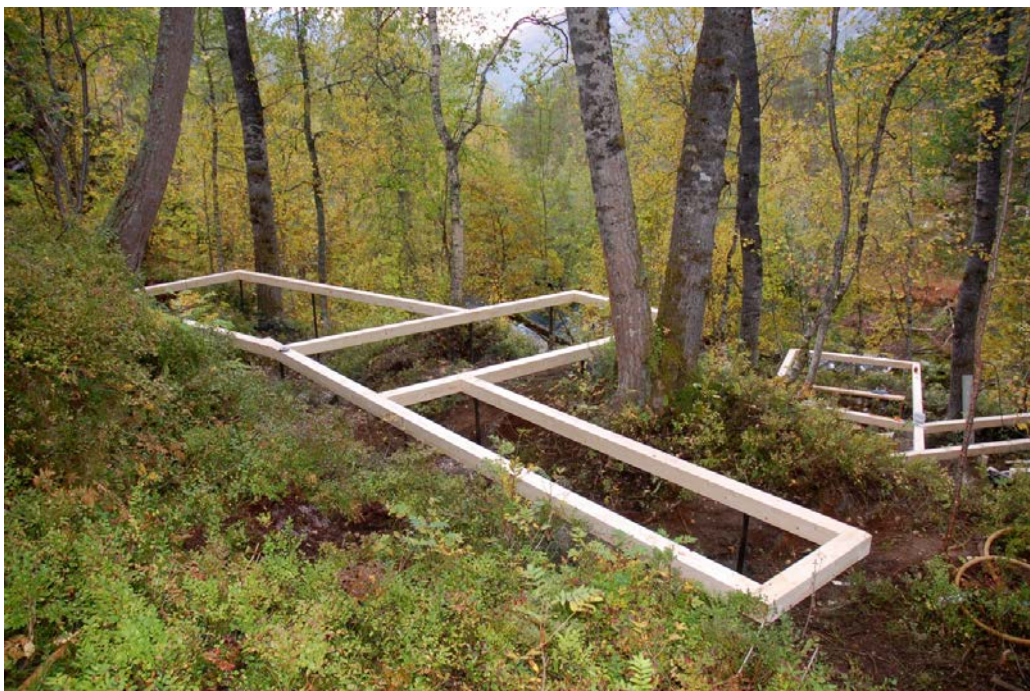
Fra oppføringen av juvet landskaps hotell, Grunnramme på stålplårer. Merk hvordan den skånsomme byggemetoden lar seg gjennomføre tett opp mot naturen. (Arkitekt: Jensen og Skodvin, foto: Juvet.com)
