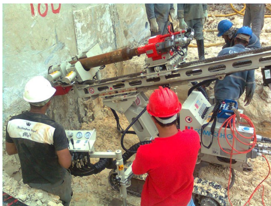
Eksempel på en liten mobil og fleksibel bore rigg, av typen Comacchio MC2D
