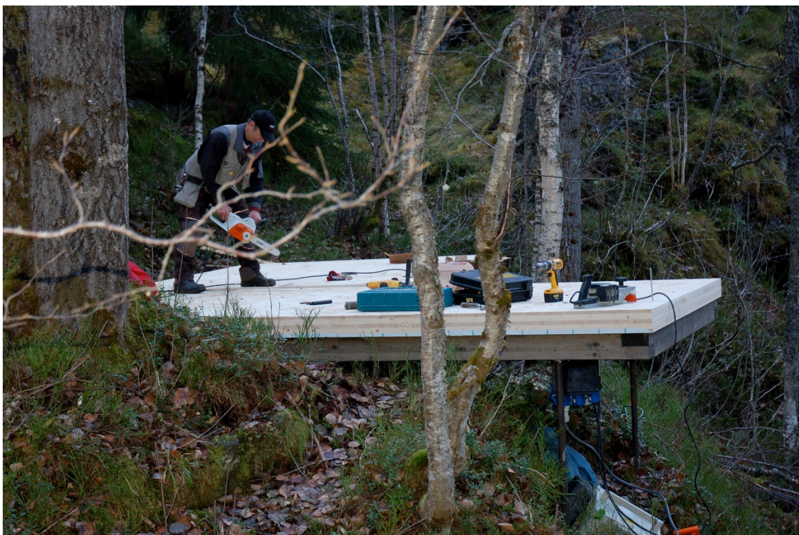
Tilpassing av massivtredekke med håndverktøy på plassen. Alle bygningselementer måtte dimensjoneres slik at de kunne håndteres for hånd på plassen. (Arkitekt: Jensen og Skodvin foto: Juvet.com)
