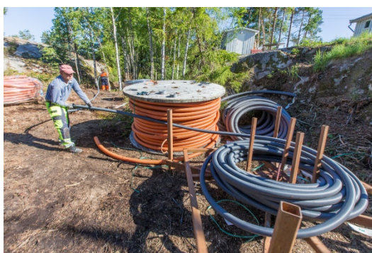
Fremføring av vann og avløpsledning til hyttefelt. Isoterm rør med frostsikring, (foto: Isoterm.no)
