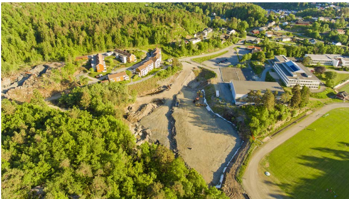
Oversiktsfoto som viser oppfyllingen av tomten og omfanget av uttak av masser fra eksisterende kolle innenfor planområdet
